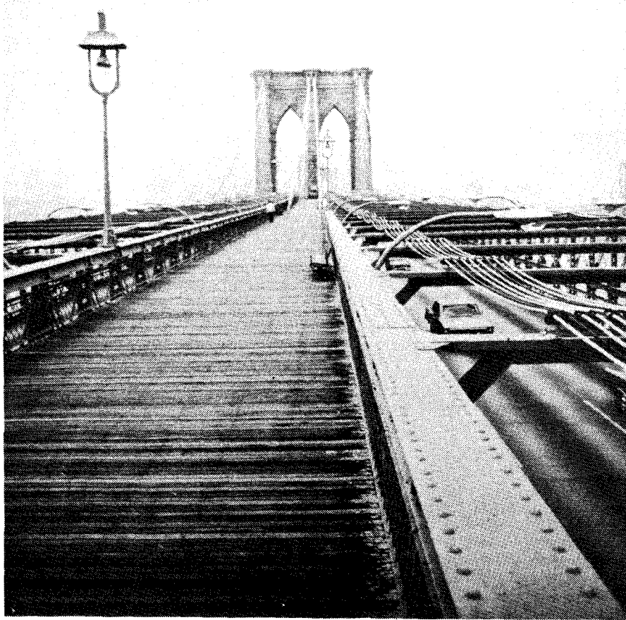
OVER DE BRUG LOOPT EEN VOETPAD DAT ZICH BOVEN DE AUTOWEG BEVINDT
